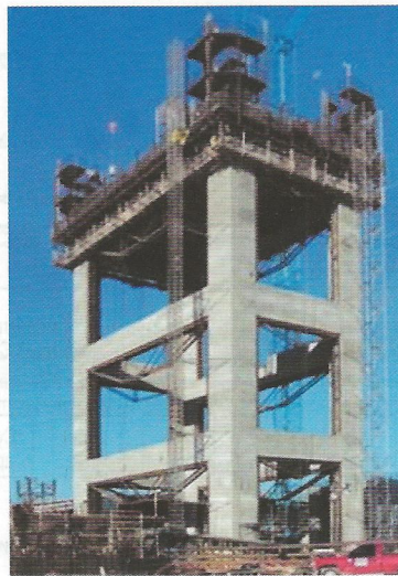
Рис. 4. Передвижная (а) и разборно-переставная (б) опалубки
